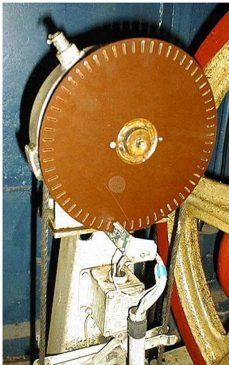
Рисунок 13 - ДСЛ и прерыватель светового потока
