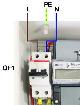
Рисунок 5 – Подключение кабеля питания шкафа
